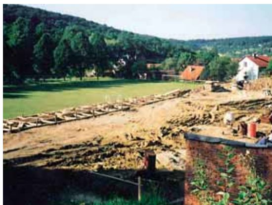
červenec 1999 – Přípravné práce pro výstavbu tělocvičny
