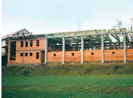
listopad 1999 – Pohled na rozestavěnou tělocvičnu z fotbalového hřiště
