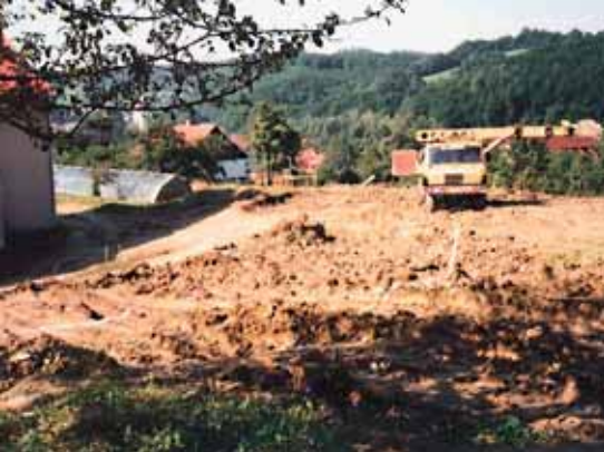
srpen 1997 – Příprava staveniště, terénní úpravy, přeložka kanalizace, pilotáž
