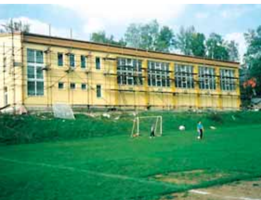
říjen 2000 – V tělocvičně byla dokončena palubovka a probíhaly dokončovací práce na fasádě
