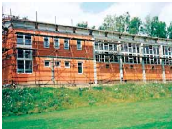
červenec 2000 – Vsazování oken v nové tělocvičně
