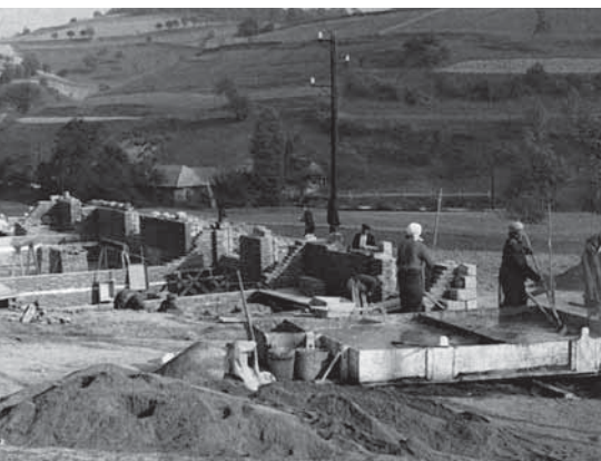
Budování základů suterénu a kamenného soklu
