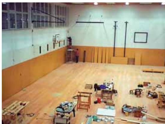
listopad 2000 – Práce při montáži vnitřního obložení tělocvičny
