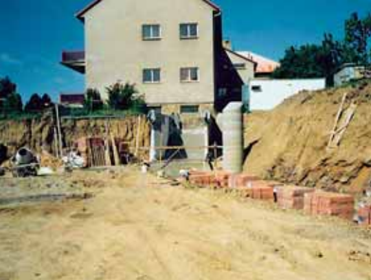
srpen 1999 – Bagrování a příprava bednění ke krčku mezi školou a tělocvičnou
