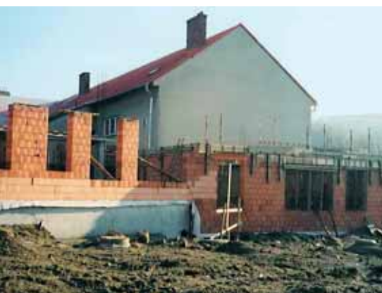
listopad 1997 – Zdění přízemí přístavby
