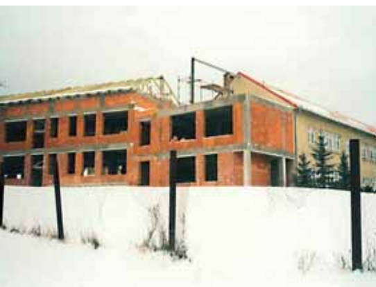
únor 1999 – Práce na zastřešení přístavby
