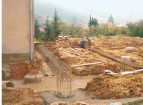
říjen 1997 – Betonování základů a spojení základů s vybetonovanými piloty
