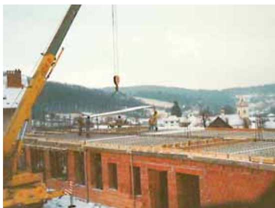
únor 1998 – Pokládání velkoplošných stropnic nad přízemím
