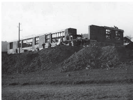
Stavba zdí I. etapy výstavby
